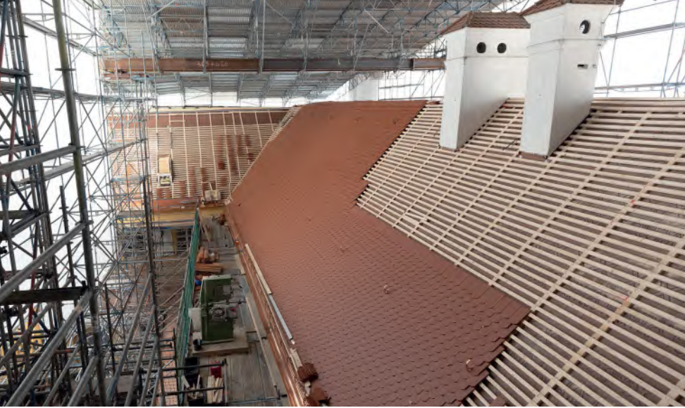
Die Sanierung und Deckung des Kardinal-Döpfner-Hauses erfolgt unter einem Wetterschutzdach.
