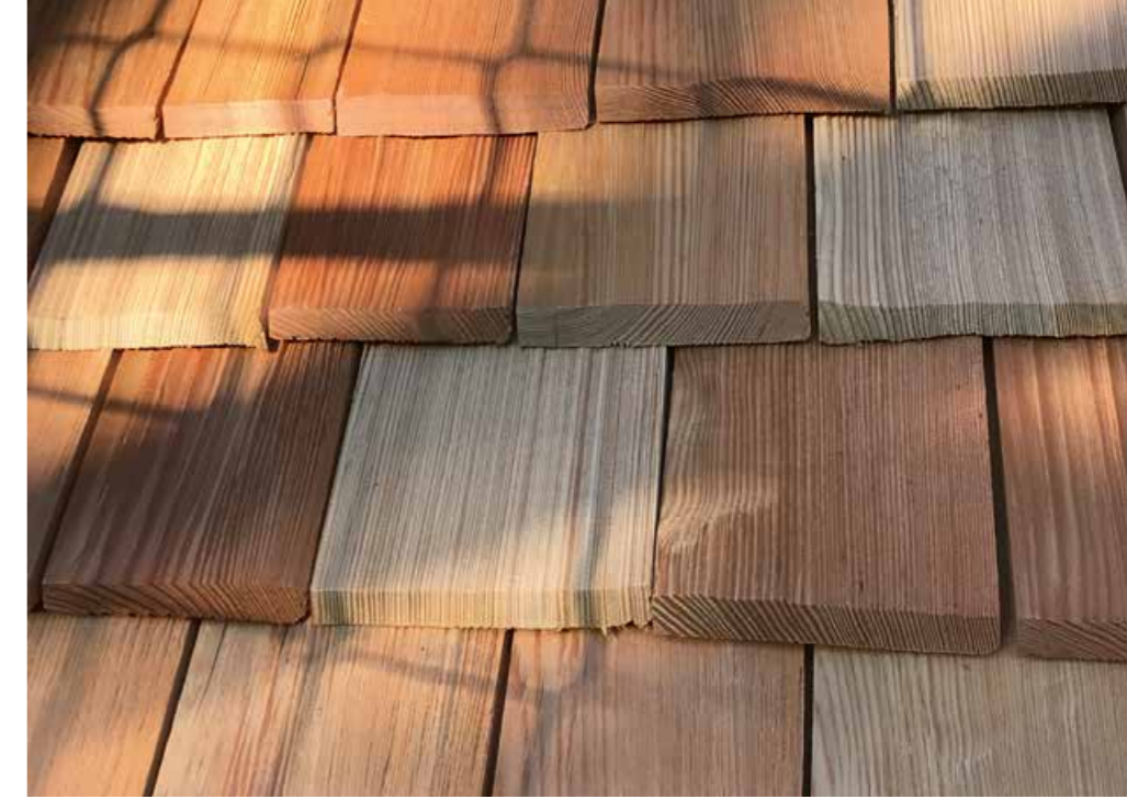
▲ Eine edle Dachdeckung für ein temporäres Gebäude: Die Holzschindeln aus Lärchenholz im Detail
